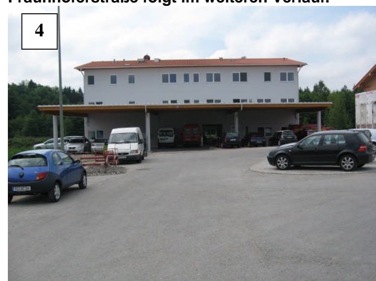
20 Parkplätze unter dem Vordach. Linken Eingang nehmen: Aufzug 2. Stock: Büro von Andreas Sauer.
